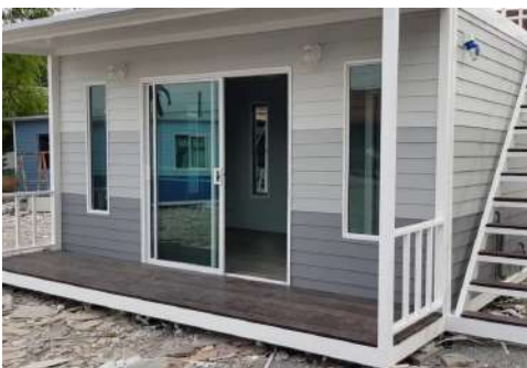
บ้านประกอบเสร็จ
