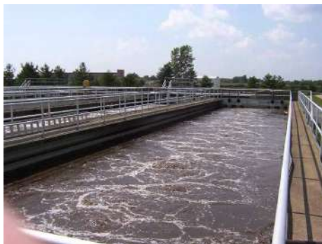
บ่อบำบัดน้ำเสีย
